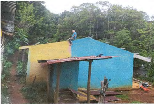
Foto 3: vista previa de techo de los baños
