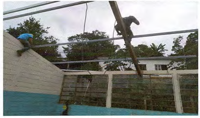
Foto 2: Instalacion de estructura metalica para techo
