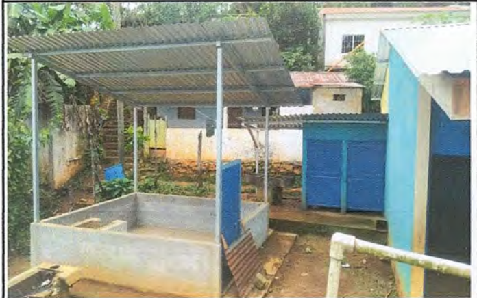
Foto 4: Vista general de avance de cocina.
